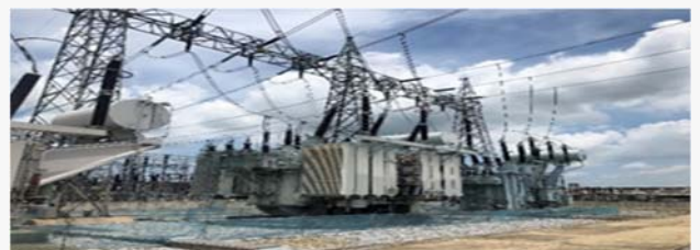
งานนำสายไฟฟ้าอากาศลงสู่ใต้ดิน
